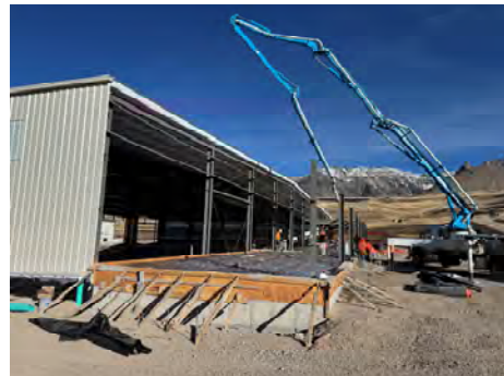
Concrete pour East Lean
