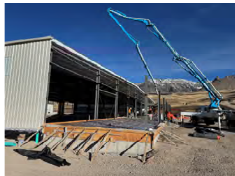
Concrete pour East Lean
